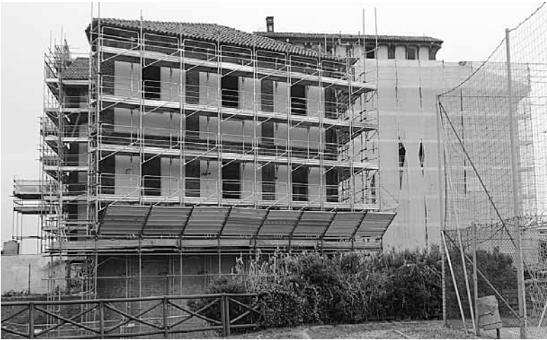
L'edificio del Caselli tutto impacchettato in fase di ristrutturazione.
