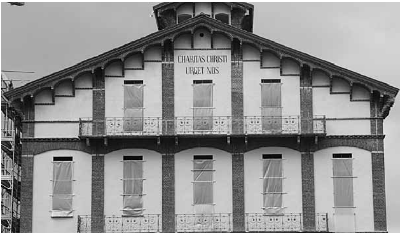
2 settembre 2025. Il grosso dei lavori esterni dell'edificio è quasi ultimato.
