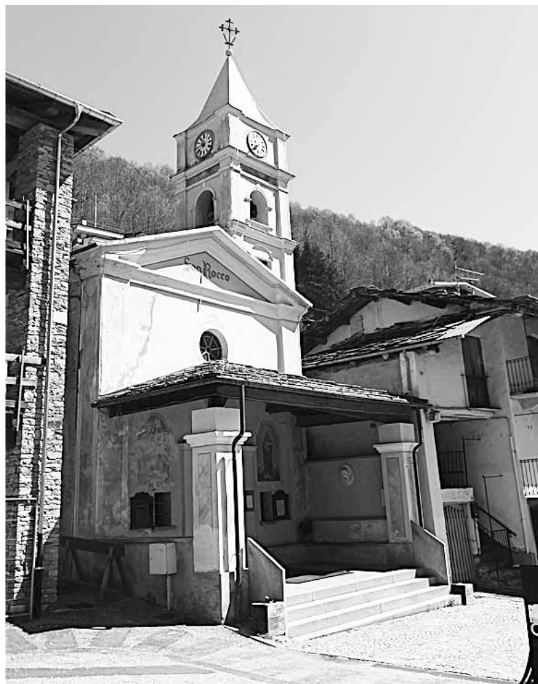
La facciata della chiesetta di San Rocco a Crissolo in provincia di Cuneo.
